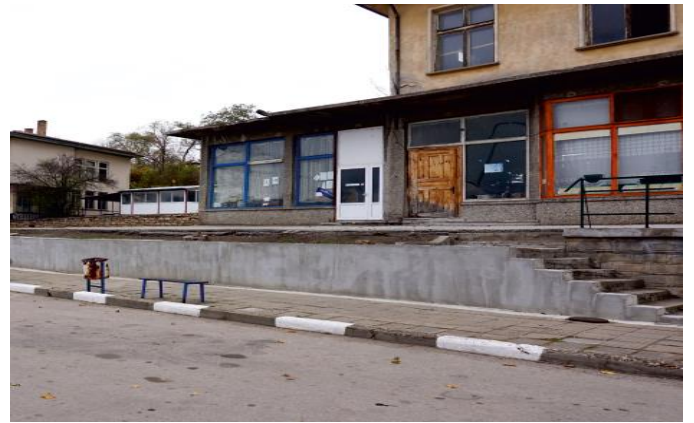
Ремонт на улична настилка в с. Деляновци, ул. „Първа“ на стойност 5 848,00 лева;
