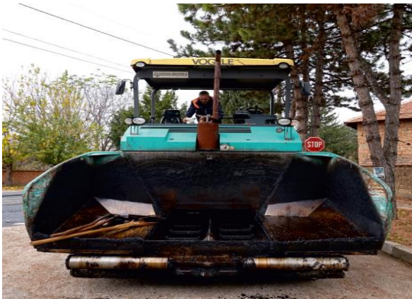
Ремонт на улична настилка в с. Драгомирово, ул. „Шестнадесета“ на стойност 31 570,00 лева;
