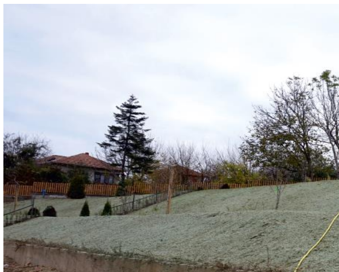
Ремонт на улична настилка в с. Червена, ул. „Втора“ на стойност 15 167,00 лева;
